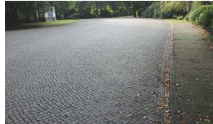
Granitkleinpflaster in der Bergstraße
