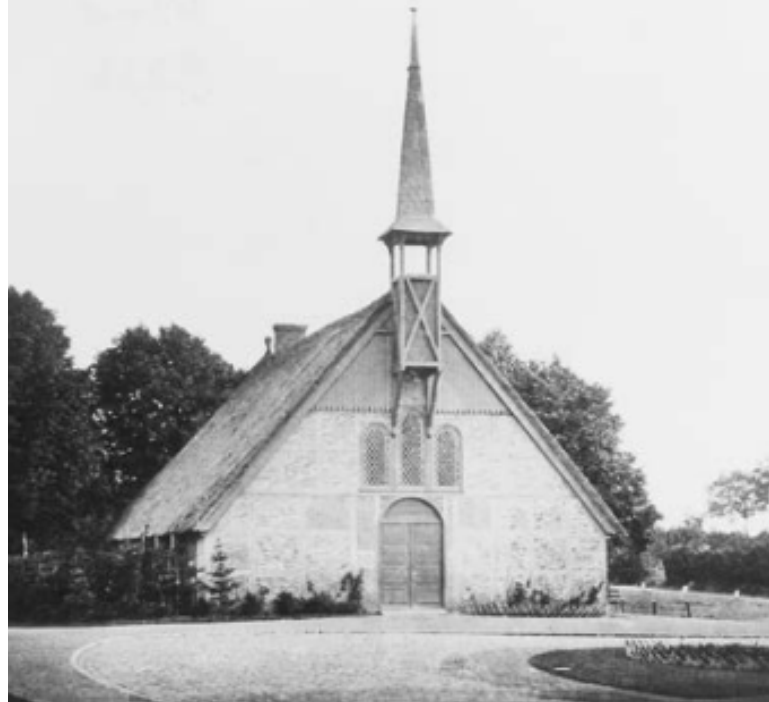
▲ Aus dem Haus des Bauern Schwen, dem Vorbesitzer des Geländes, wird die erste Friedhofskapelle.
